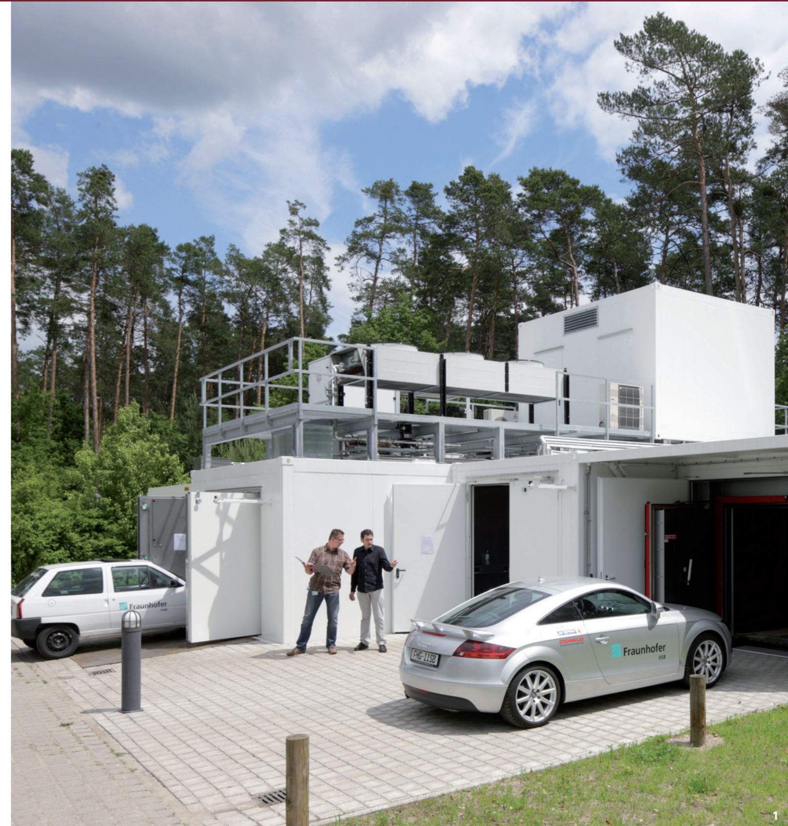
1 Testzentrum für Elektrofahrzeuge am Fraunhofer IISB in Erlangen.
